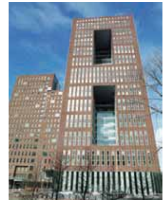
Prinsenhof, Den Haag. Prinsenhof is multifunctioneel. Met woningen, woonwkerwoningen, kantoren, horeca aan Prinsenhof Plaza, een groot healthcenter, een ****hotel, een riante parkeergarage en een compleet pakket services en diensten is Prinsenhof een van de meest luxe woon-, werk- en ontspanningslocaties in de regio Den Haag. IKON Verso biedt een sluitsysteem op maat en de mogelijkheid om aan de wensen te voldoen van de verschillende partijen.
